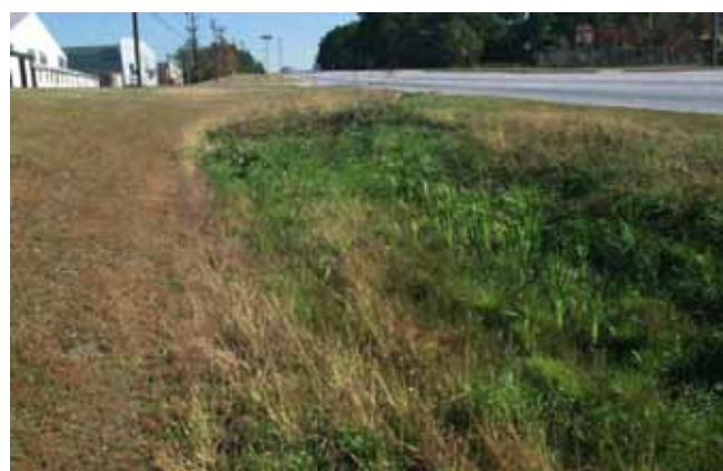
Figure 11.55 Exemple d'aménagement de noue avec retenue permanente.
