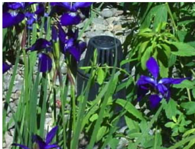
Figure 11.35 Trop-plein mis en place dans un système de biorétention (GVRD, 2005).
