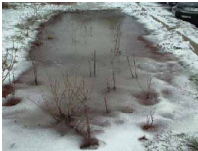
Figure 11.37 Fonctionnement d'un système de biorétention pendant l'hiver (TRC, 2007).
