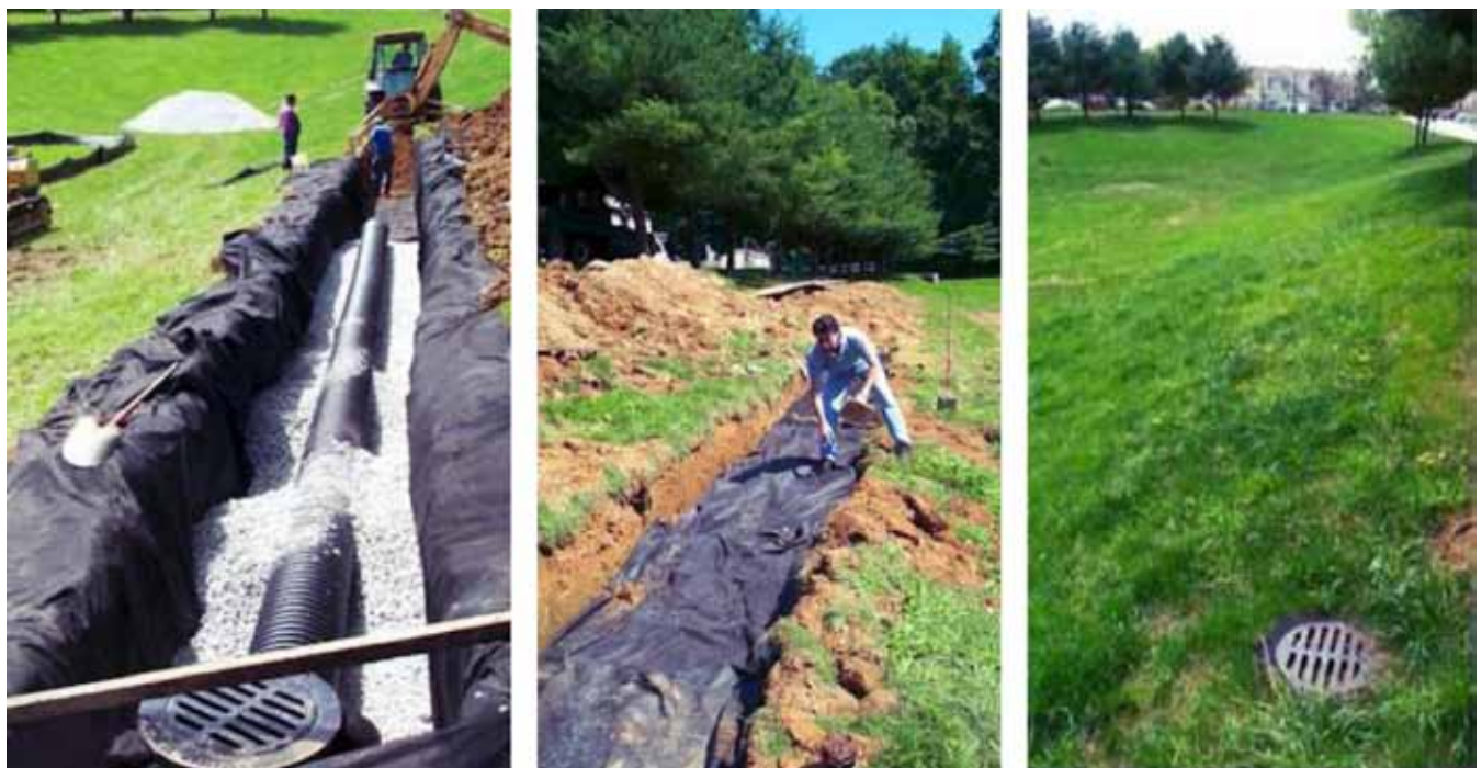
Figure 11.61 Installation d'un système avec conduites perforées.
